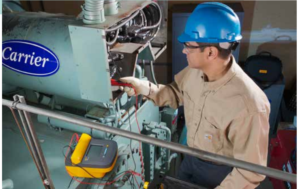
Kazan sisteminin çok sayıda parçasını kontrol etmek için bu Fluke 1555 gibi bir yalıtım test cihazı kullanabilirsiniz.
