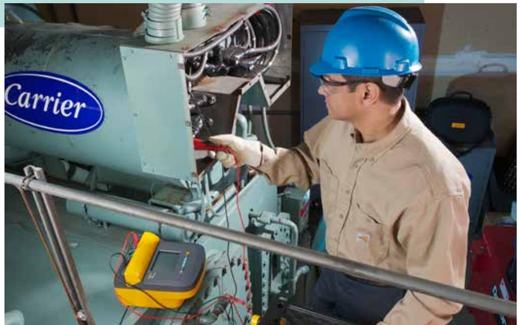
Pode utilizar um medidor de isolamento, como este Fluke 1555, para verificar muitas partes de um sistema de caldeiras.
