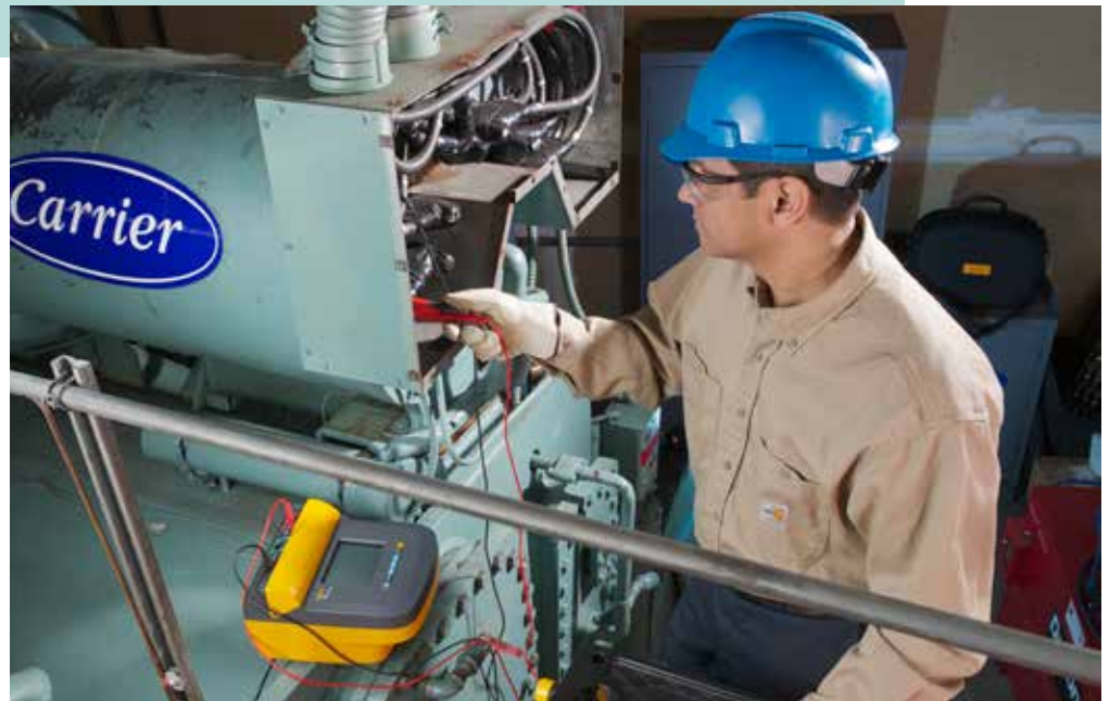
Zur Überprüfung vieler Komponenten einer Kesselanlage können Sie ein Isolationsmessgerät wie z. B. das Fluke T1555 verwenden.
