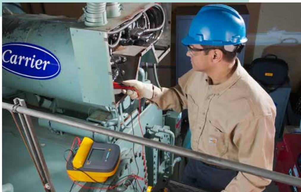
Vous pouvez utiliser un testeur d'isolation comme le Fluke 1555 pour contrôler les différents éléments de la chaudière.
