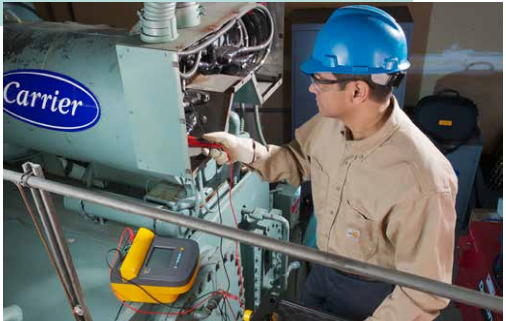
Monet kattilajärjestelmän osat voi tarkistaa esimerkiksi tämän Fluke 1555 -eristysvastusmittarin avulla.
