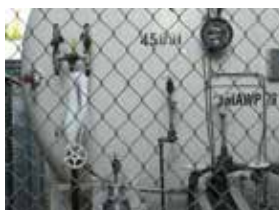
Un site d'inspection complexe.
