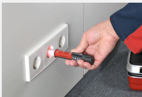
Testowanie gniazd elektrycznych pod kątem obecności napięcia AC i jego polaryzacji
